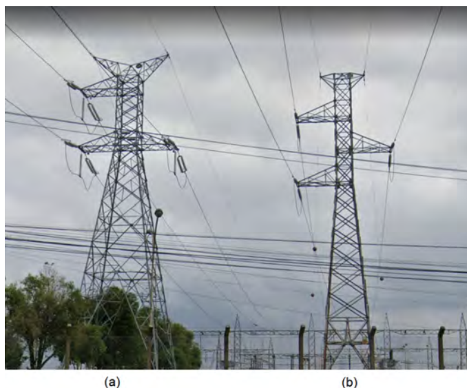
Figura 15 – Disposição triangular de condutores.
