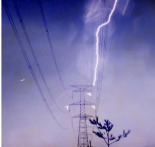
Figura 54 – Registro de descarga no cabo guarda de uma linha de transmissão de 500 kV com ocorrência de backflashover .
