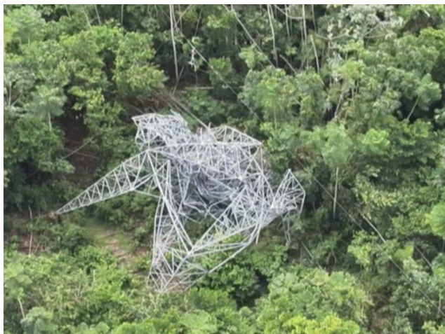
Fotografia 15 – Colapso de torre de transmissão em área florestal
