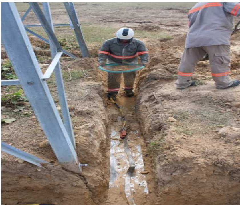
Fotografia 14 - Instalação de aterramento com composto de grafite em solo de alta resistividade (LT Axia Energia - Eletrobras).
