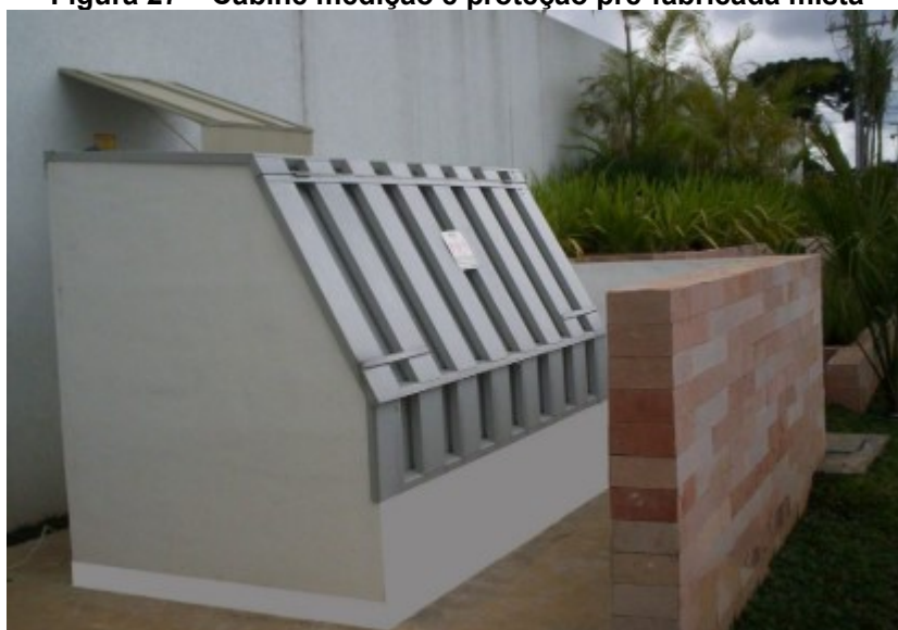
Figura 27 – Cabine medição e proteção pré-fabricada mista
