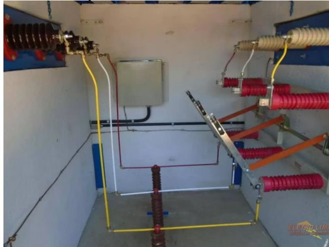
Figura 30 – Cabine pré-fabricada mista – módulo seccionamento
