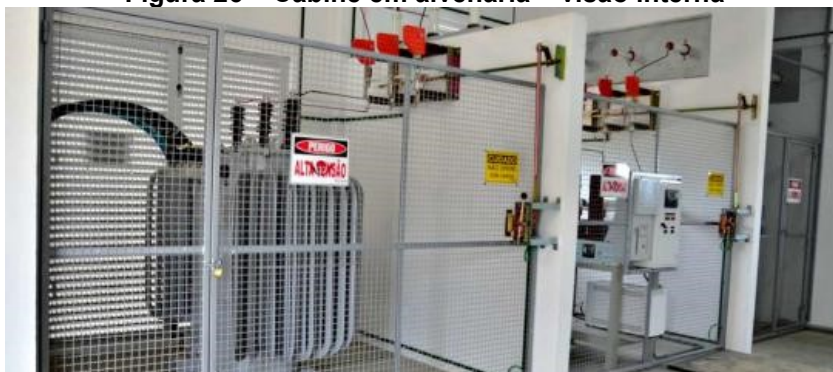
Figura 26 – Cabine em alvenaria – visão interna
