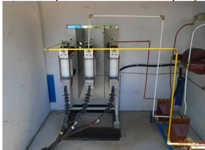
Figura 31 – Cabine pré-fabricada mista – módulo proteção geral
