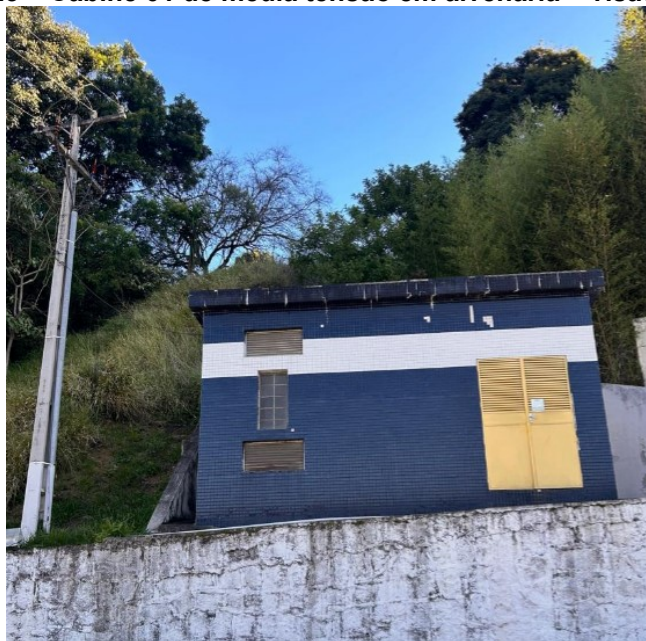
Figura 23 – Cabine 01 de média tensão em alvenaria – visão externa
