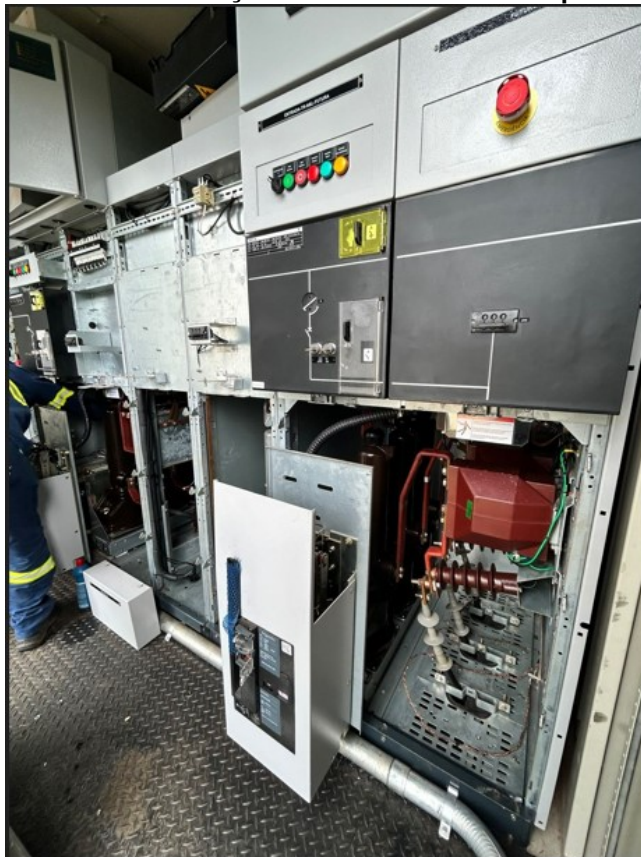
Figura 36 – Cabine de medição em média tensão compacta certificada
