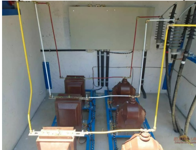
Figura 29 – Cabine pré-fabricada mista – módulo entrada / medição concessionária
