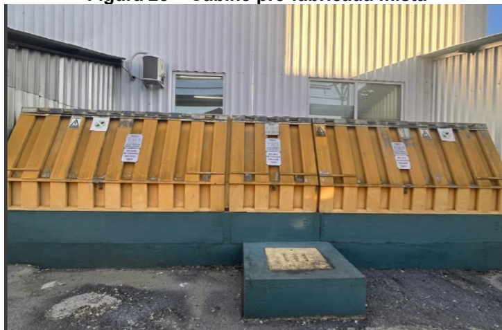
Figura 28 – Cabine pré-fabricada mista
