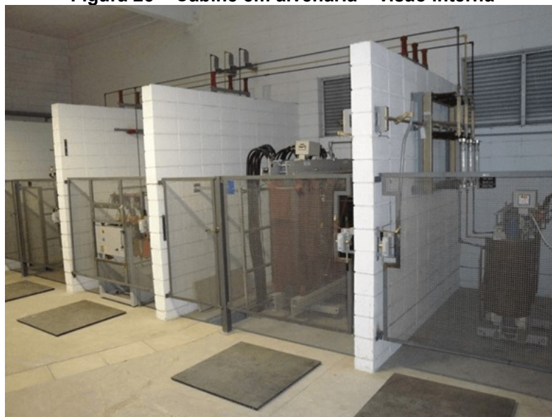
Figura 25 – Cabine em alvenaria – visão interna
