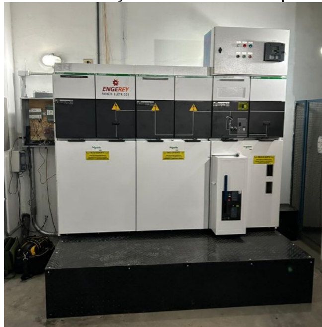
Figura 35 – Cabine de medição em média tensão compacta certificada
